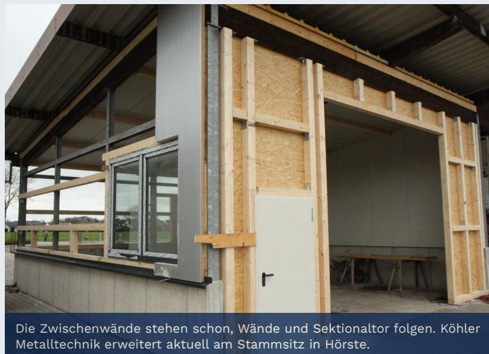
Die Zwischenwände stehen schon, Wände und Sektionaltor folgen. Köhler Metalltechnik erweitert aktuell am Stammsitz in Hörste.
